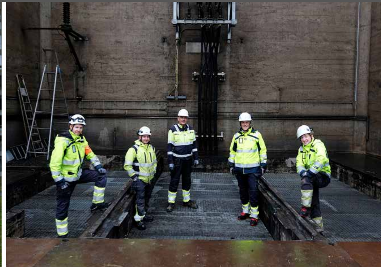
Venter på ny transformator ved Roligheten transformatorstasjon i Porsgrunn. Fra venstre: Joachim Holmøy Døj, André Esaiassen, Svein Næss, Jens Bjørn Staff og André Gregersen i den tomme transformatorcellen hvor ny T1-trafo skal inn. Foto: Per Eirik Hekkelstrand.
