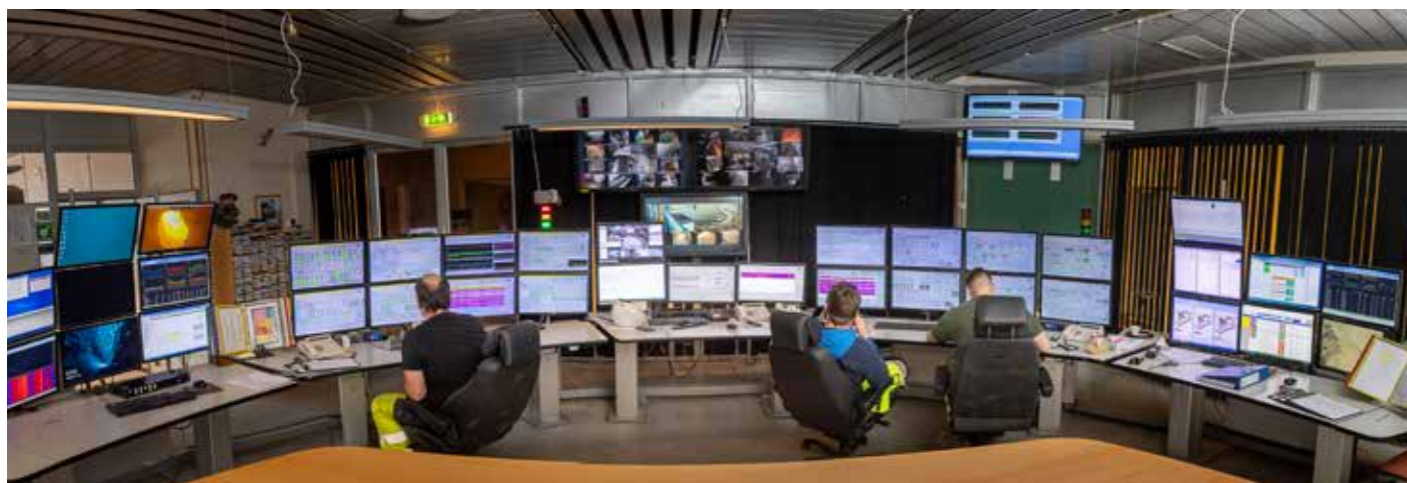
Hele fabrikk til Norcem styres fra dette kontrollrommet.
